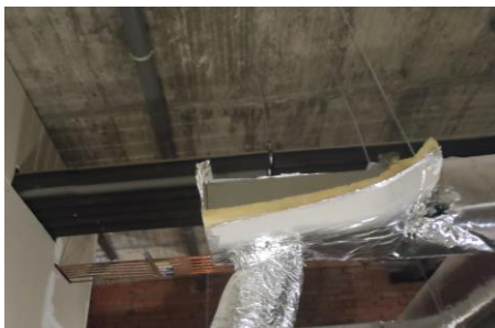
Fig. Clima y Saneamiento instalación de bandejas de condensado
