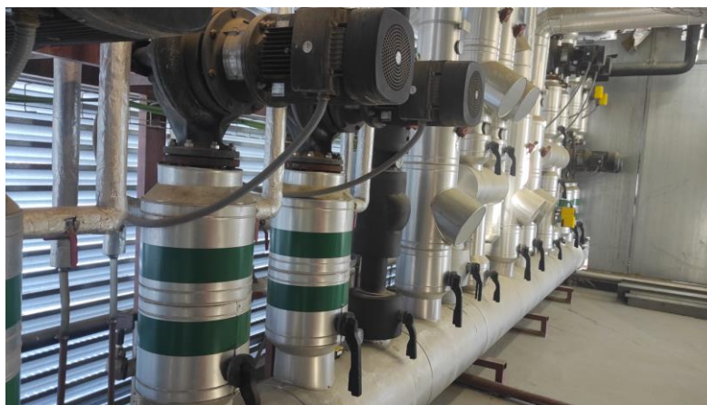
Fig. Colector frío producción centralizada.
