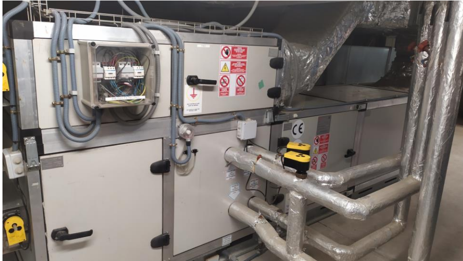
Fig. Climatizador CL.03 existente para sala Examen RM
